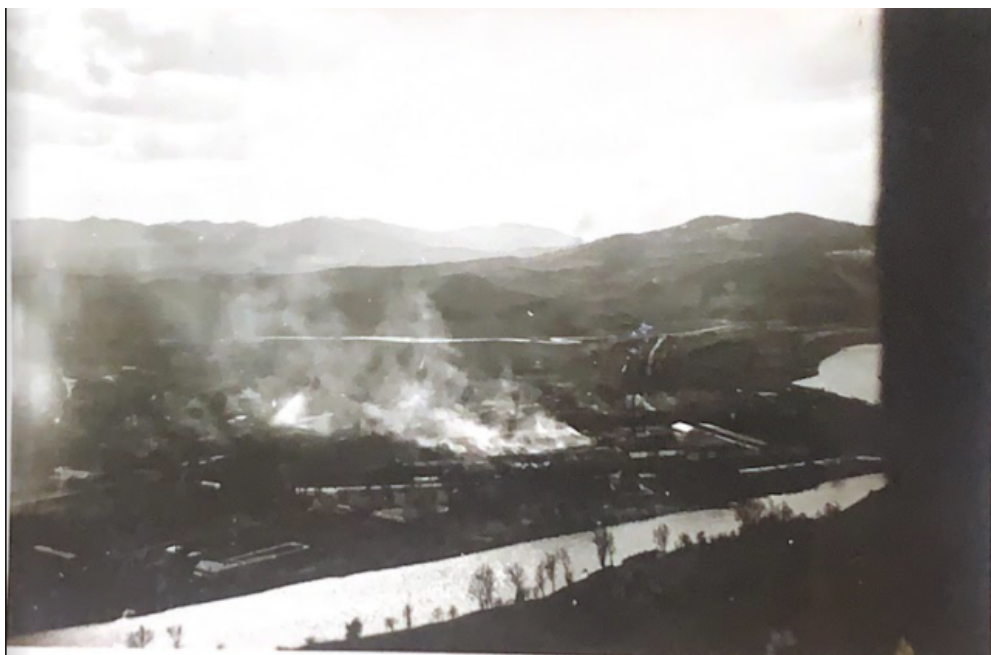
Obr. č. 4: Horiaca budova Sloveny (Zdroj: Súkromný archív p. Dvoreckého)
