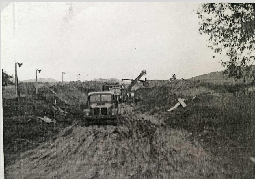
Obr. č. 4: Výstavba príjazdovej cesty k pamätníku
