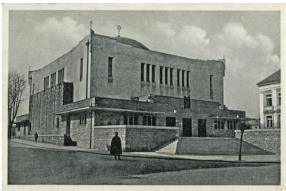
Obr. č. 7: Budova synagógy v roku 1935
